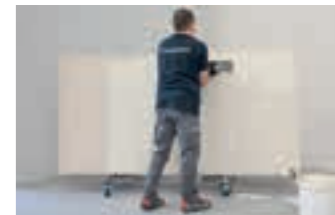
IT 4_ Stendere il collante sul retro della lastra utilizzando l'apposita spatola a denti quadri (3x3 mm) e accertarsi che le righe dell'ultima stesura siano nella stessa direzione di quelle della spalmatura della lastra. Durante la fase di stesura, la lastra dovrà essere in posizione verticale e fissata al telaio di movimentazione con ventose di sicurezza posate sopra al carrello per il trasporto con ruote.
