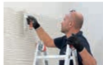
IT 2_ Distribuire la colla sulla parete utilizzando l'apposita spatola a denti inclinati (10x10 mm), stendere il collante superando di 5/10 cm la superficie della lastra.
