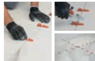
IT 7_ Come per tutti i formati di grandi dimensioni, si suggerisce l'utilizzo dei distanziatori autolivellanti (levellers) per ottenere un risultato estetico ottimale.
