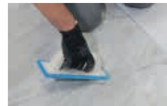
IT 8_ Si raccomanda di alternare e orientare i pezzi in modo da creare una distribuzione naturale del disegno e delle venature. Si consiglia una stuccatura in tinta con il prodotto, mantenendo una fuga minima di 2 mm (come prevede la normativa europea).
