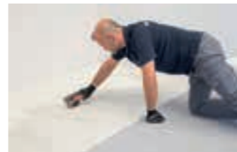
IT 2_ Distribuire la colla sul pavimento utilizzando l'apposita spatola a denti inclinati (10x10 mm), stendere il collante superando di 5/10 cm la superficie della lastra.
